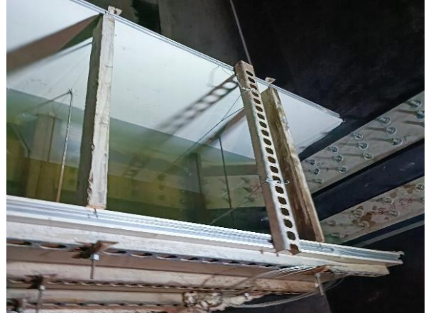
圖 8 新建鋼構槽體內部儲水試驗
