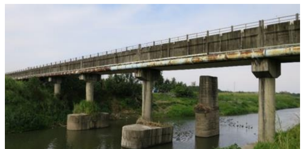
圖 2 朴子溪第二代渡槽(1980 年)
