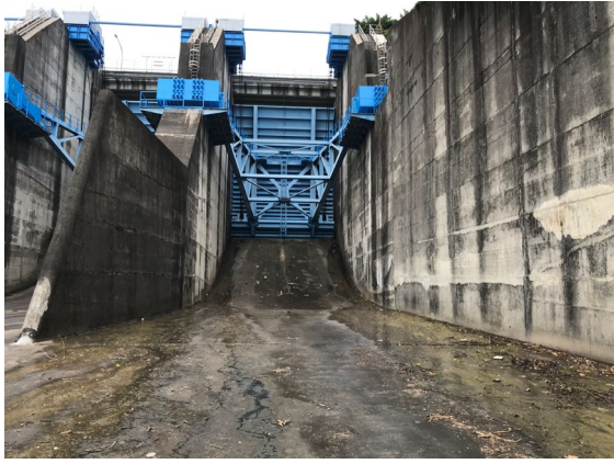
圖 4.2.1 溢洪道洩槽檢查照片
