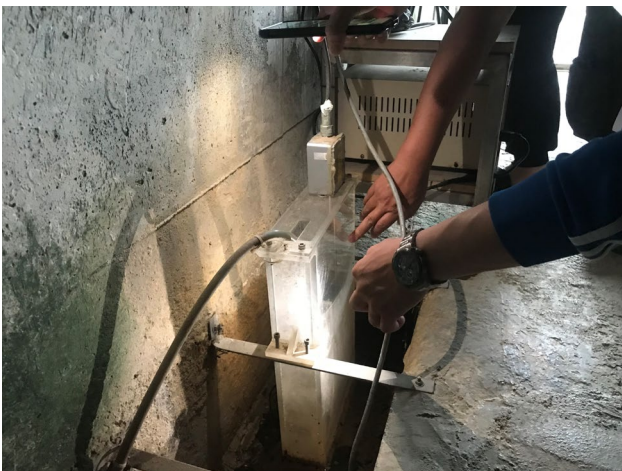
圖 3.1.11 W4 量水堰現況照片
