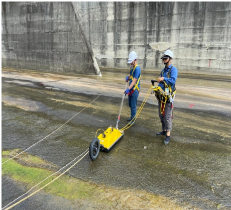
圖 4.2.2 溢洪道透地雷達檢測現場作業照片
