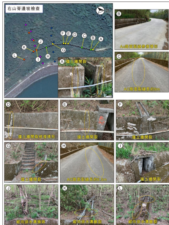
圖 4.5.3 右山脊邊坡現場檢查照片(1/2)
