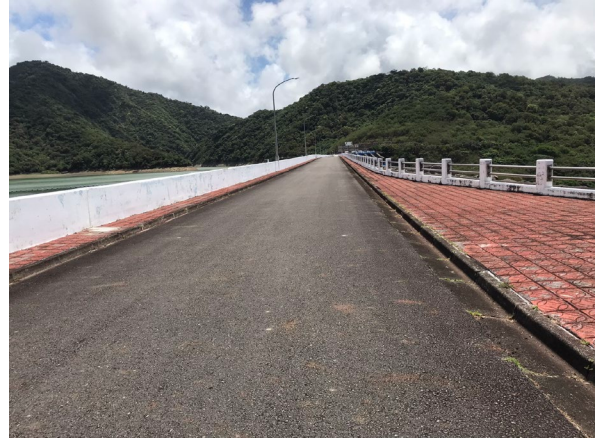
圖 4.1.4 壩頂道路檢查照片
