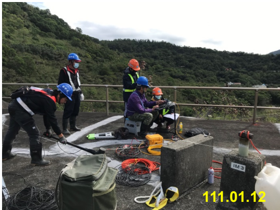
圖 4.1.3 135 平台波速測量現場作業照片
