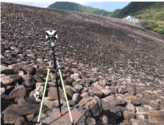
圖 3.1.10 現場高程測量
