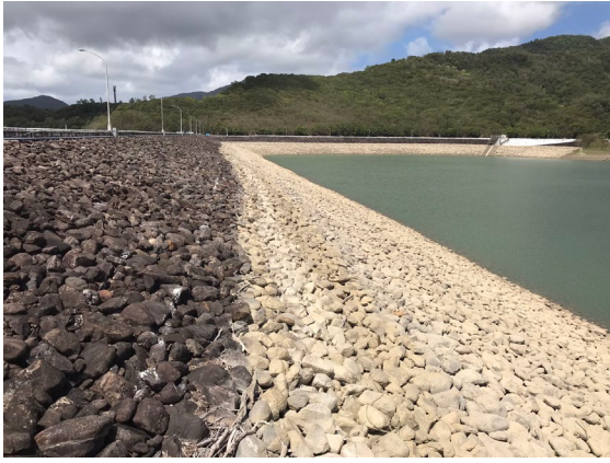
圖 4.1.1 大壩上游坡面檢查照片
