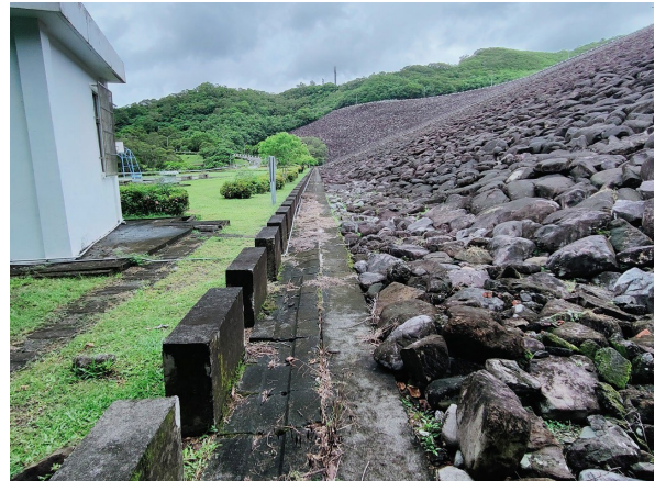
圖 4.1.5 壩座檢查照片
