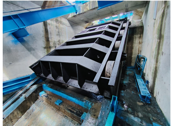
圖 4.3.1 取排水設施現場檢查照片
