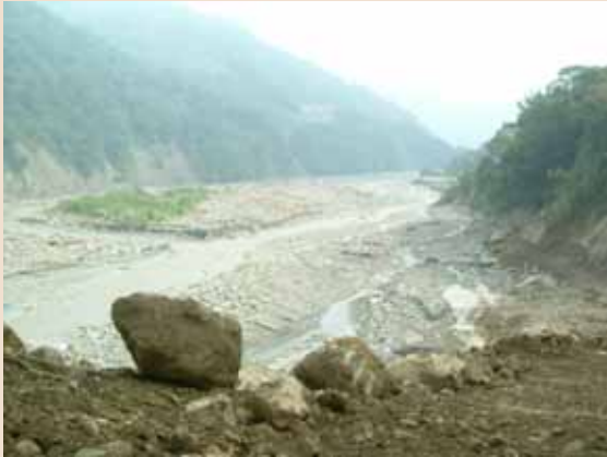
台21線100K於颱風期間溪水暴漲導致約150M路基流失
