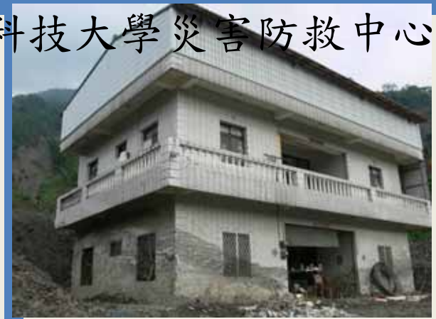
被崩塌土石掩埋房屋
