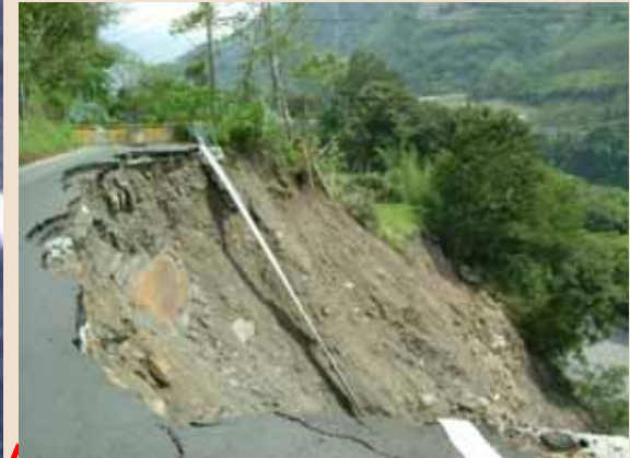
投60鄉道往東埔發生崩塌，下邊坡崩塌長約45M，寬約40M
