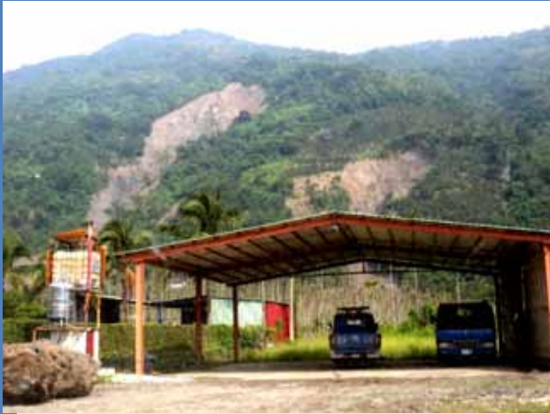
新發社區東側山坡發生多處崩塌
