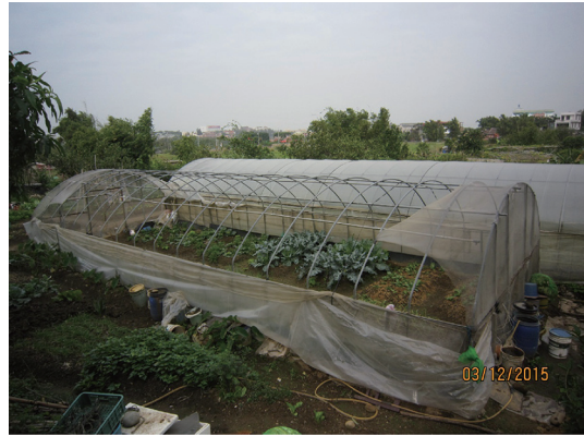
圖 1 蘇迪勒颱風吹壞之半圓柱形溫室之照片
