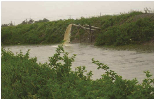
圖 2 後鎮大排周邊魚塭排水狀況
