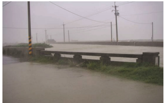
圖 4 莫拉克颱風時後鎮大排周邊淹水情況
