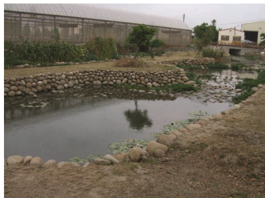
圖 3.1 砂岡圳姊妹湧泉第一期(上圳)圳路生態化工程完成面貌
