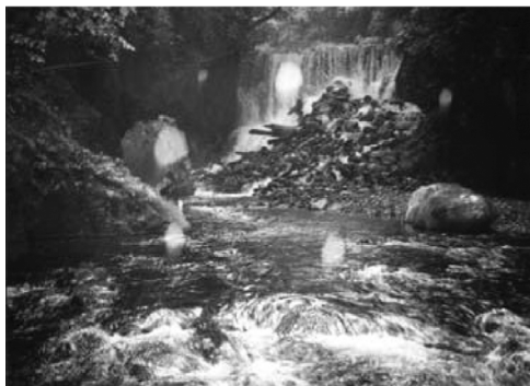
(e)高山溪三號壩拆除前
