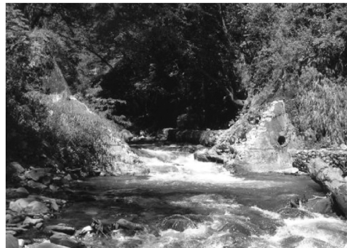
(h)高山溪四號壩拆除後
