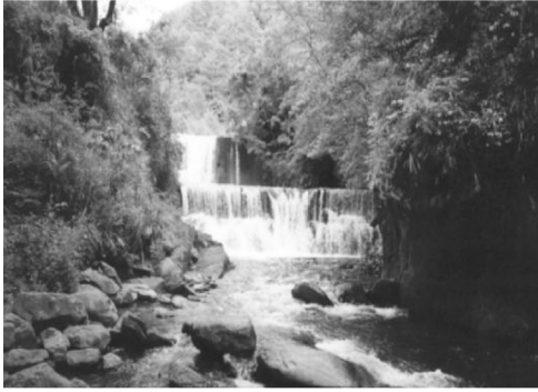
(a)高山溪一號壩拆除前
