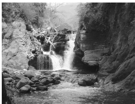
圖 6 高山溪二號壩拆除後漂流木堆疊形成殘材壩
