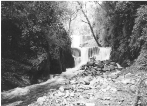
(c)高山溪二號壩拆除前
