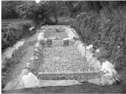
圖 6 蘆葦床礫石介質填充施做過程
