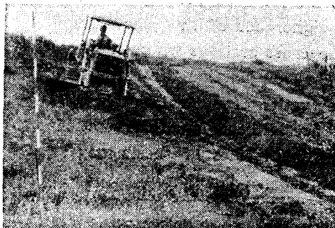
圖20. 陡坡地由上而下進行整修，使用角鏟，作成積土帶。
