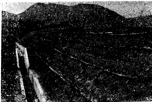
圖15. 在填方邊坡上作編柵工及間隔植草
