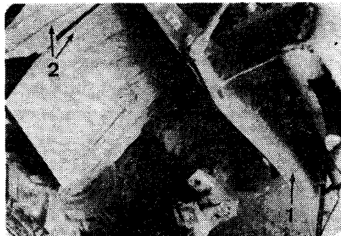
圖 4 後方擋土板(1)及側方擋土板(2)
