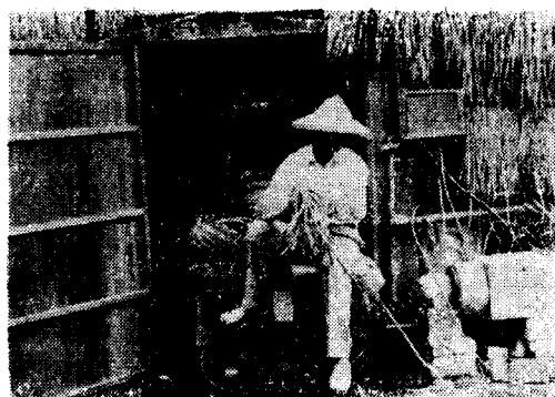
照片四 人工收放電纜的方法：視堆肥上床機行進方向而行收放。作業員以腳控制機械進退而以手收放電纜。
