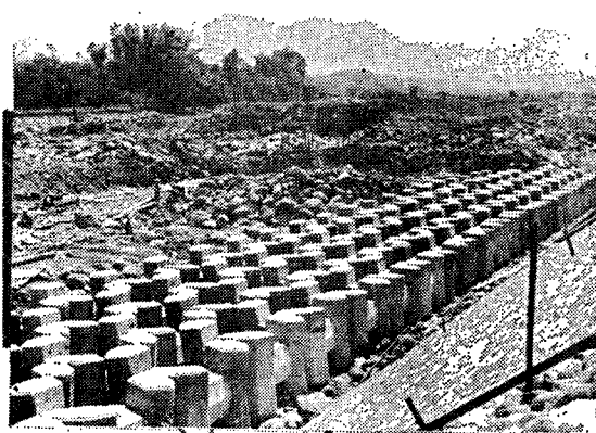
圖五 嘉義縣中埔鄉仁義潭導流堤（施工中） 70年3月攝
