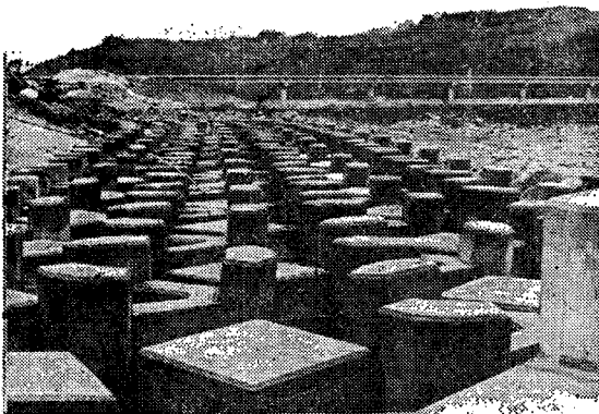
圖三 臺東縣卑南大溪臺東大堤（施工後） 70年5月初完工，70年5月13日攝
