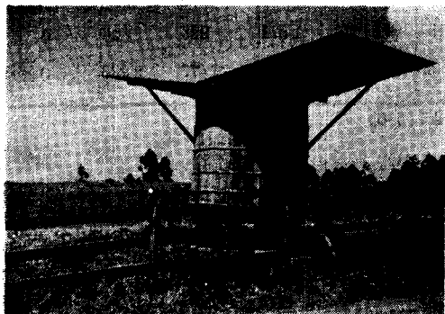
圖一 擴大承水面積的接水槽 (作者原圖)
