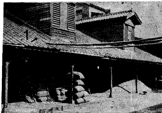
圖 1. 大甲農會 1~16 號土塊倉①外貌②小隔倉③原有出倉帶式輸送機④改善後之抽換式螺旋出倉機螺旋承套。
