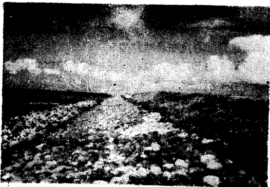
三、會文海埔地二號排水門外之塊石護坡
