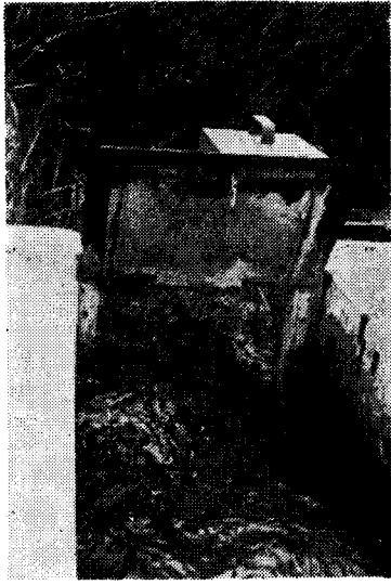
照片7 田區進水門開啓安置情形
