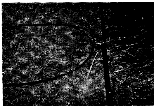
照片 1 現場導管與支管之配置情形
