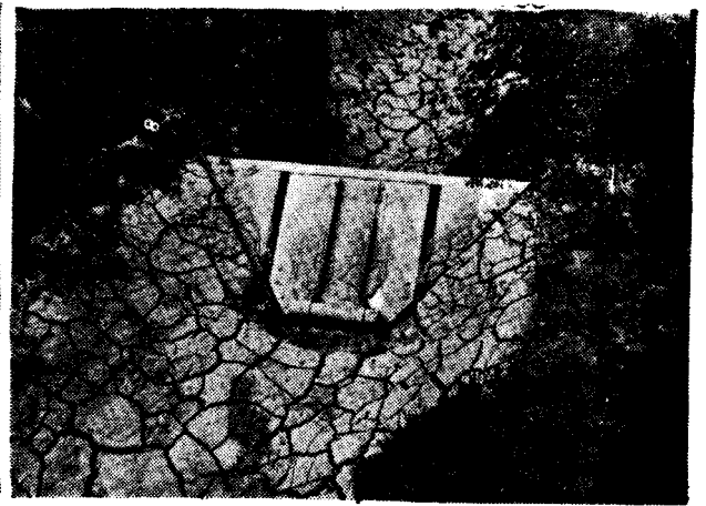
圖十一 土渠之梯形壓力水閘
