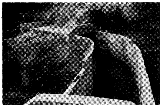
能高大圳區渡槽工程
