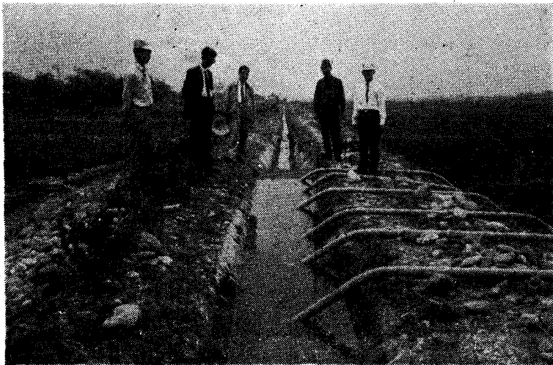
屏東合作農場利用 PVC 倒虹吸管灌溉情形
