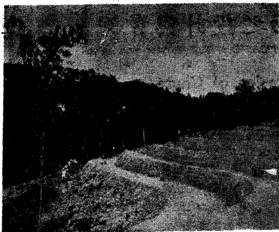
水土保持——平塔工程
