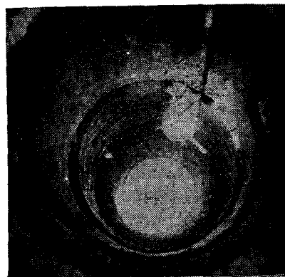
爐內環式送風口全景
