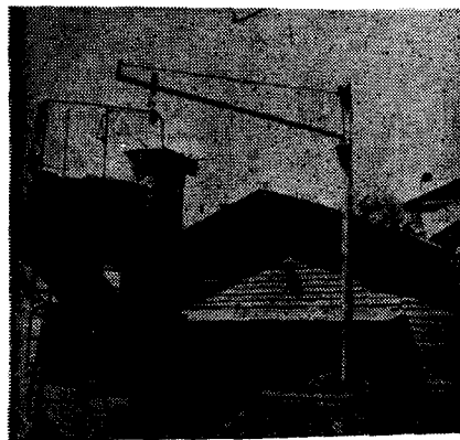
石門水庫克難之加料手吊車遠景
