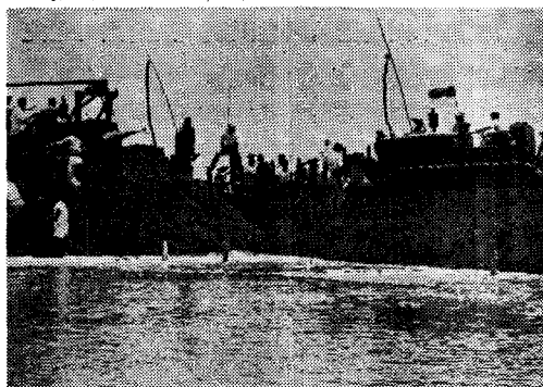
防潮堤潮口閉合瞬間
